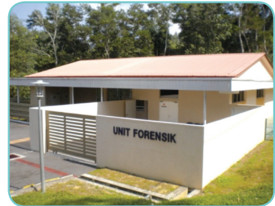
Unit Forensik Hospital Kuala Kubu Baru
